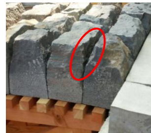
図 1 輪石の接合状況
