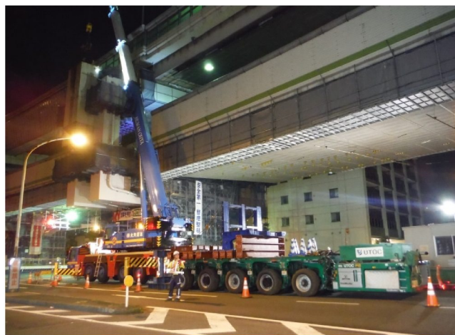
写真-1 120tf油圧クレーンによる 上層柱ブロックの撤去状況
