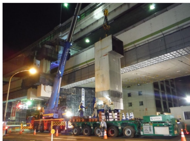
写真-2 長尺ブロック回転システムへの 上層柱ブロックの固定状況
