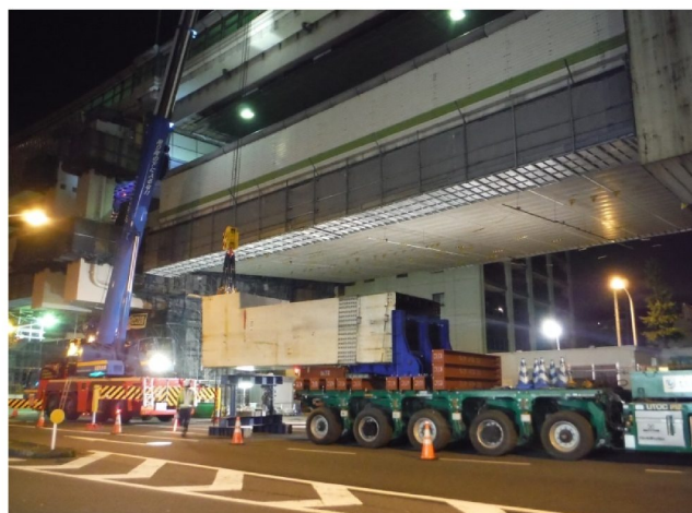
写真-4 上層柱ブロックの横倒し完了
