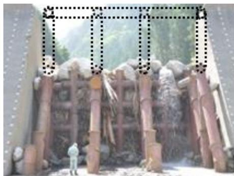
写真-1 梨子沢第1砂防堰堤被災状況
