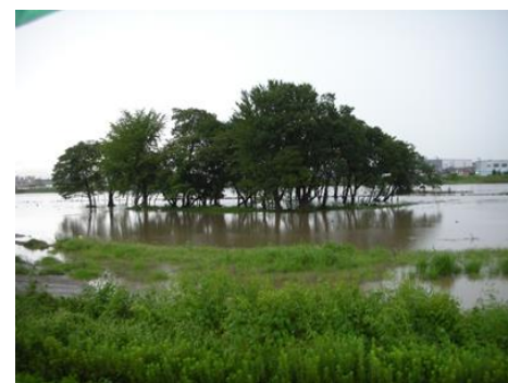
写真9 9月大雨により冠水した施設
