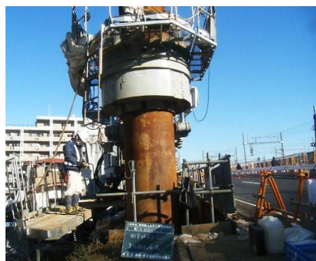
写真-2 鋼管杭の昼間施工状況
