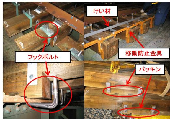
写真-3 橋マクラギ固定部材
