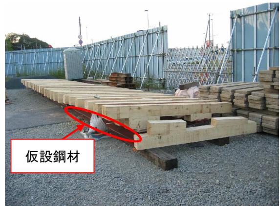
写真-2 橋マクラギの事前調整(仮設用)
