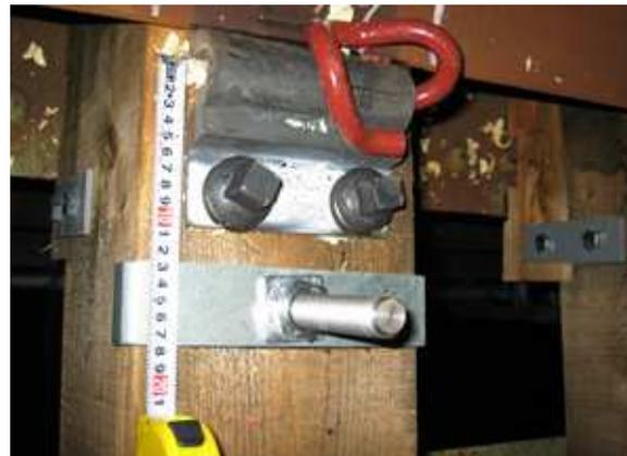
写真-4 締結装置とフックボルトの離隔
