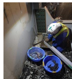
図-4 横構接合状況
