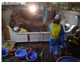
図-3 横桁架設状況
