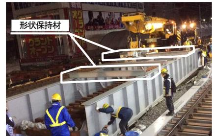
図-6 工事桁形状保持材
