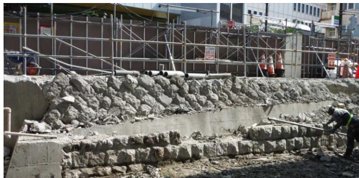
写真-1 石積み護岸現況写真
