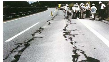
写真-1 注入材による補修例<sup>1)</sup>
