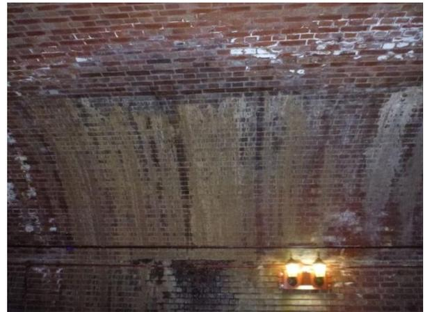
写真-2 漏水状況
