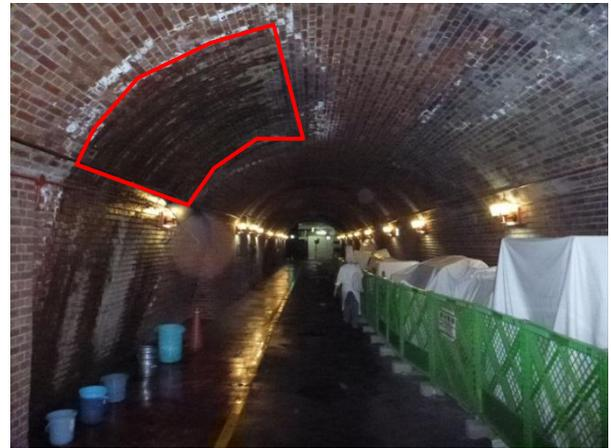
写真-1 漏水箇所
