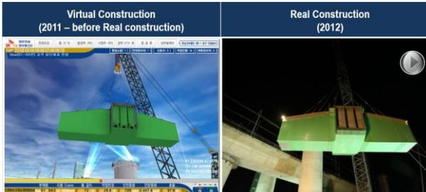
図-1 BIM 使用時における仮想施工と実施工との比較<sup>2)</sup>
