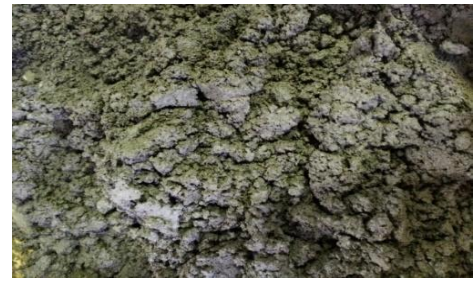
写真-2 GCL/S=100%モルタルの練り上がり後の様子
