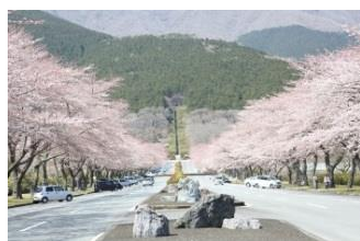
写真-2 山側のランダバウト
