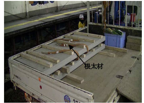
図－４ PC板根太材設置状況
