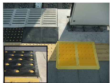
図－７ ゴムマット養生
