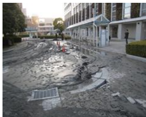
写真1 液状化被害
