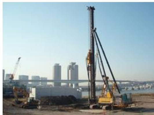
写真-1 深層混合処理工法
