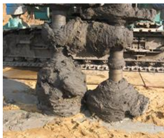
写真-2 実施工で共回りを起こした際の攪拌翼の様子
