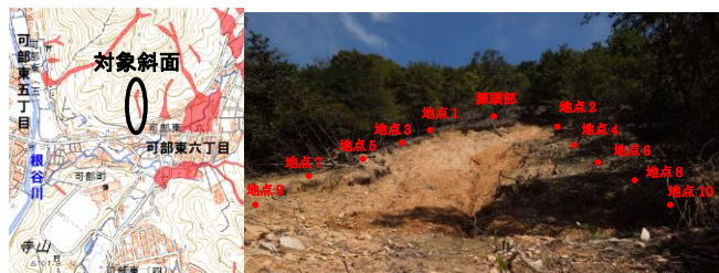
図-2 崩壊発生斜面の位置と様子
