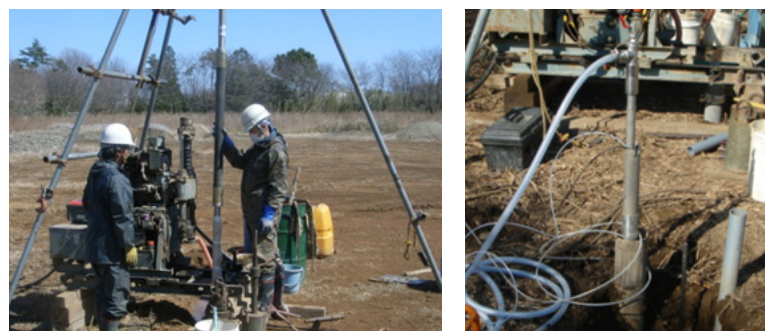
(a) 原位置パイピング試験機器設置状況
