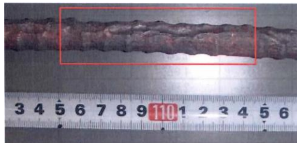
図-1 腐食の偏り 1)
