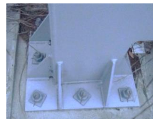
写真-2 支柱基部
