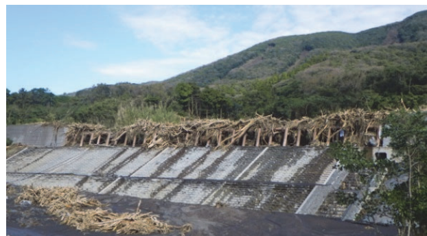
写真-1 伊豆大島における土石流の捕捉状況
