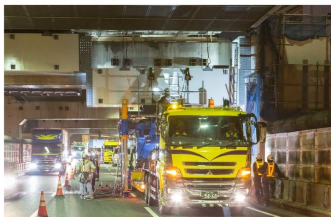
写真-3 ジャッキアップ状況(1)
