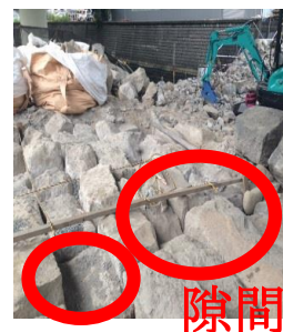
図 1 輪石の接合状況
