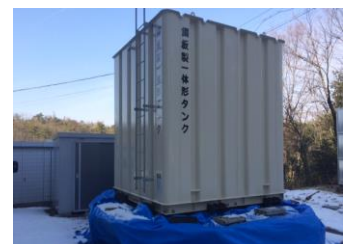
写真-2 鋼板タンク
