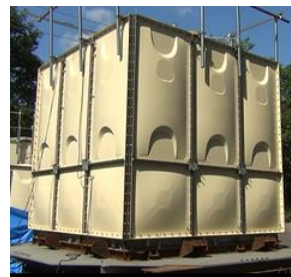
写真-3 FRP タンク
