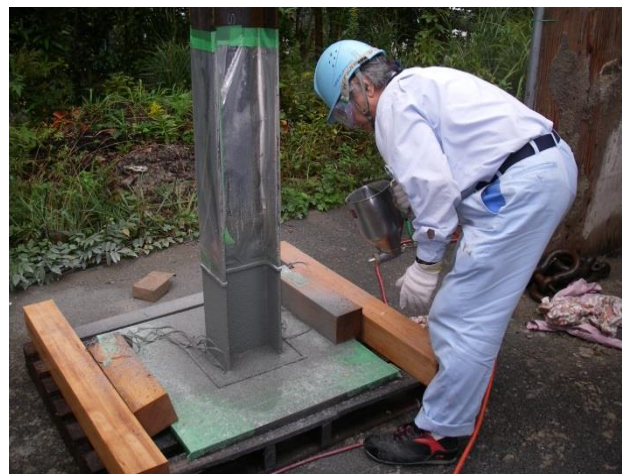
図 1.1 PCM 吹付け作業
