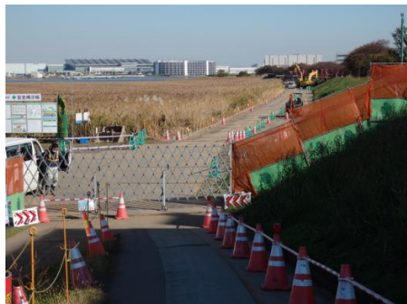
図 3. 堤防工事の様子
