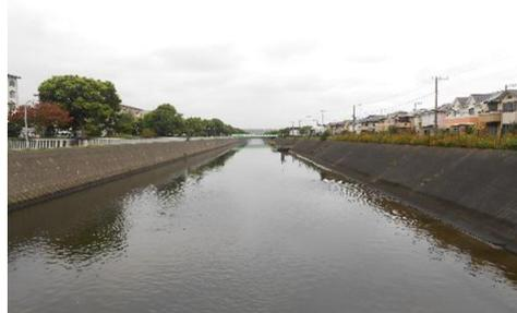
図-1 護岸をコンクリート化した河川
