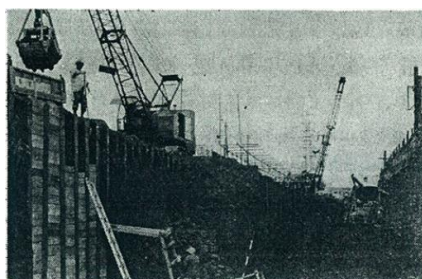
図 5. 船橋・津田沼間半地下部掘削
