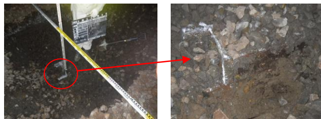
図 6. 試掘工事の様子
