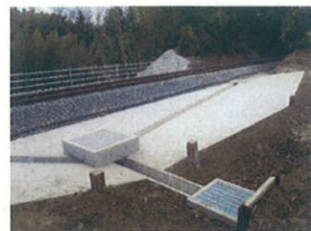
図 11. 線路側溝改良
