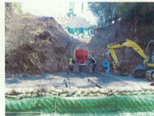
図 13. 砕石投入状況
