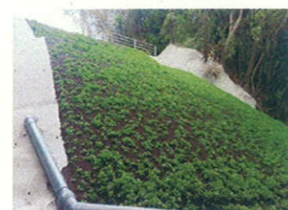
図 10. 厚層基材吹付
