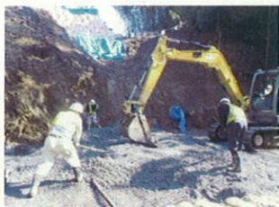
図 7. 盛土敷均し状況
