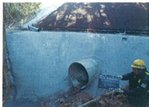
図 4. 暗渠設置及び改良土埋戻し コンクリート吹付
