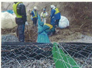
図 8. 排水ドレーン設置
