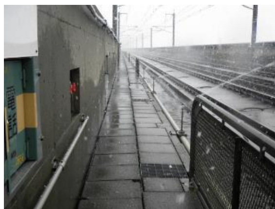
図-2 高架橋上の消雪散水状況
