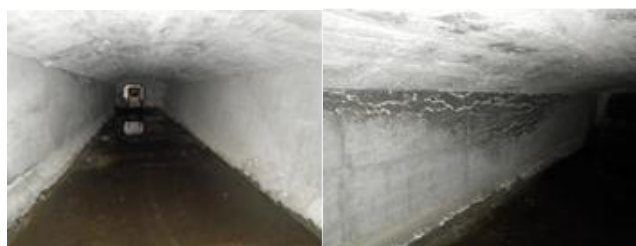
図-5 高架橋ボックス桁内部状況
