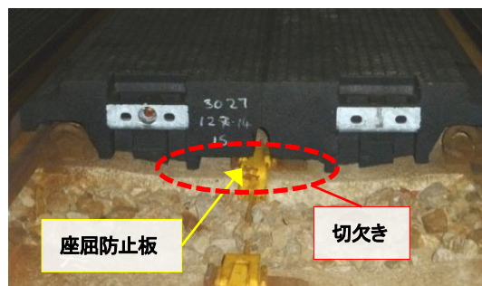
写真－1 座屈防止板切欠き部
