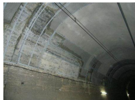
写真-2 トリカルネットによる対策
