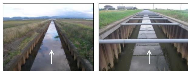
Case 1 自立式護岸形式 Case 2 切張式護岸形式
