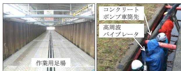
写真-5 検討対象の鋼矢板水路
