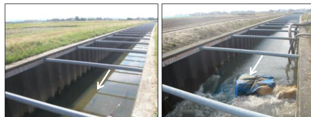
平常時の実測流量 0.3\text{m}^3/\text{s} 降雨時の実測流量 3.1\text{m}^3/\text{s}
