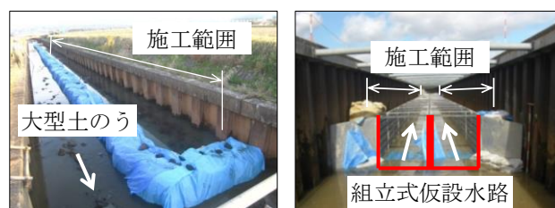
(A) 大型土のう (B) 組立式仮設水路
