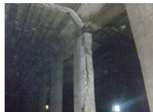
図3 中柱の変状
