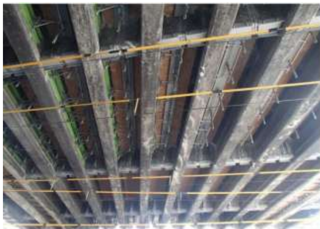
写真-3 切断防護工設置完了
