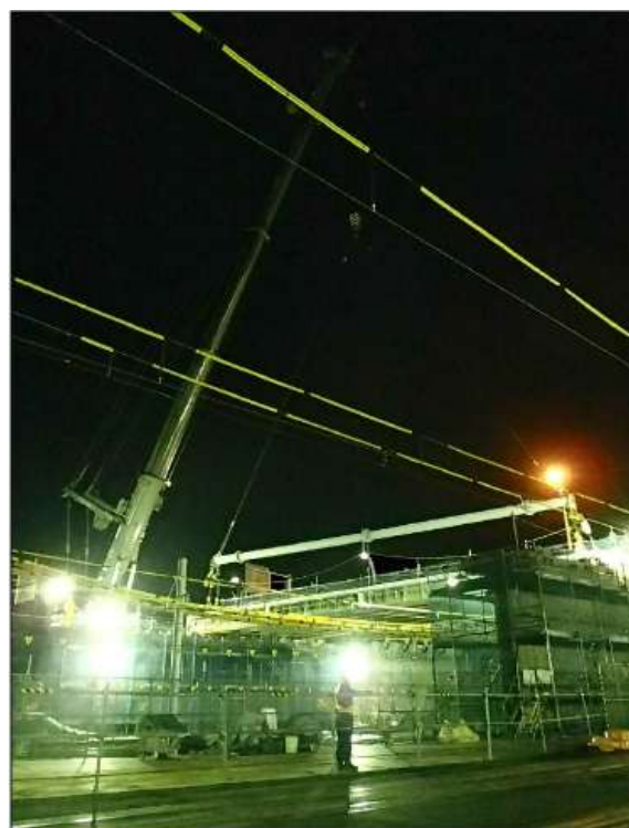
写真-5 既設PC桁撤去状況
