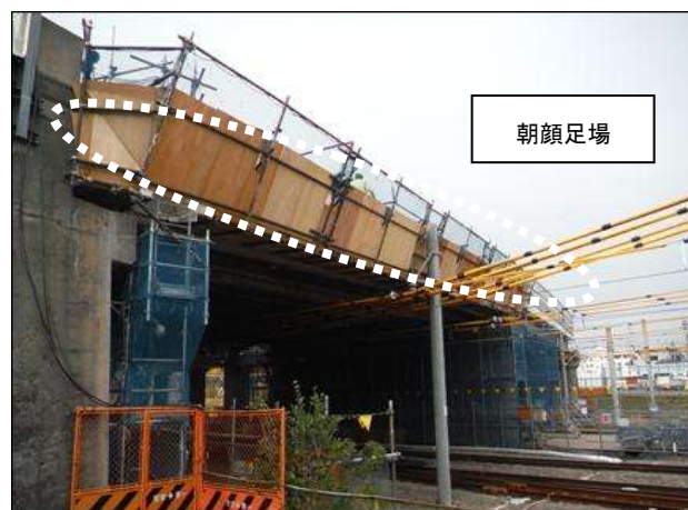
写真-1 足場設置状況
