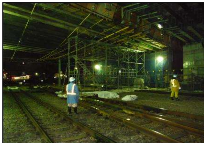
写真-4 切断防護工設置状況
