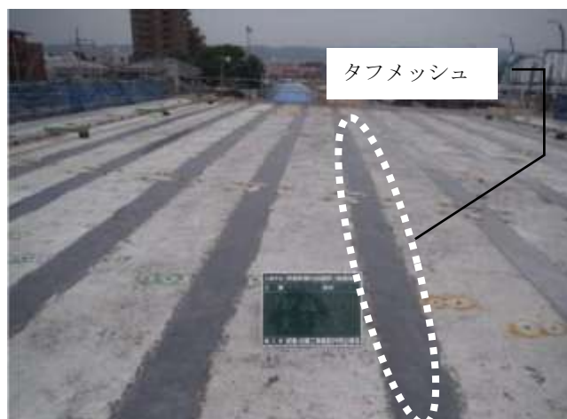
写真-2 タフメッシュ設置状況
