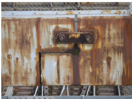
写真-3 ゲルバー支点部状況写真
