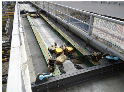
写真-4 吊天秤設置状況写真
