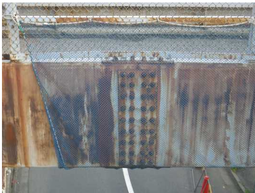
写真-2 桁添接部状況写真
