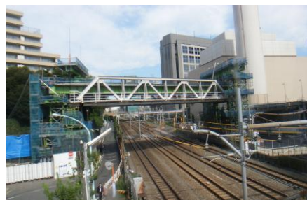
写真－1 トラス橋りょう引出し前
