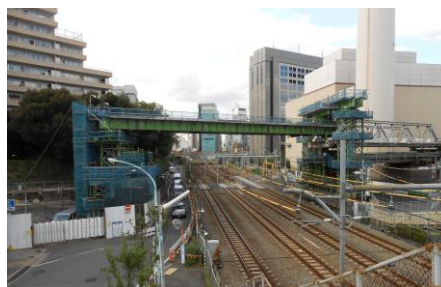
写真－2 トラス橋りょう引出し前
