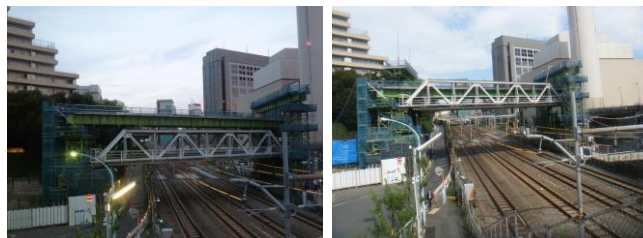
写真-3 トラス橋りょう吊上げ状況 (左：吊上げ前、右：吊上げ後[H=3.0m])
