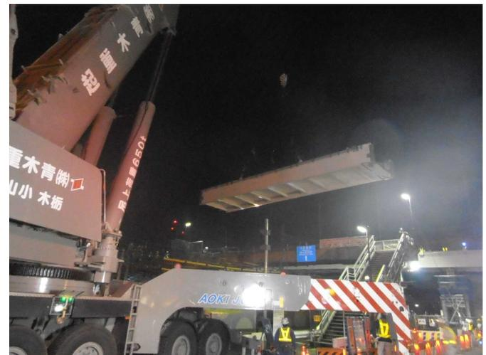
図-4 桁架設(待機時)の様子
