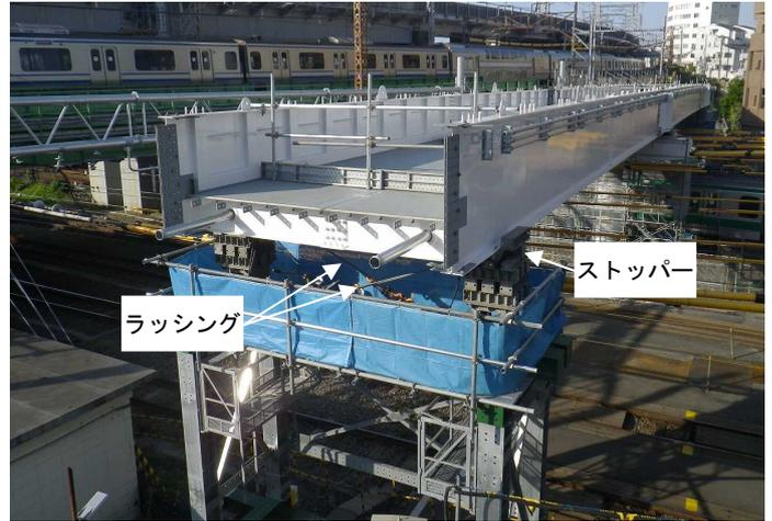
図-2 架設中の耐震設備(仮ベント)
