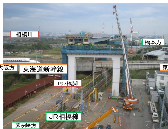
写真-1 架設箇所
