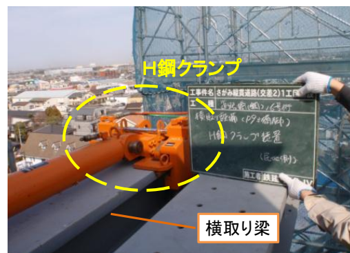
写真-4 横取り架設後 耐震設備
