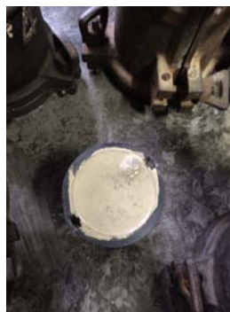
写真-5 GCL50%打設後
