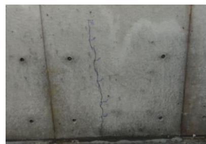
写真-2 実物大の型枠試験状況(左)と温度ひび割れ状況(右)
