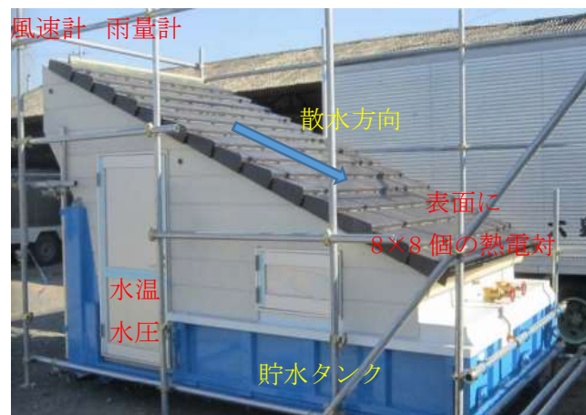
図-1 屋根散水システムの実験施設
