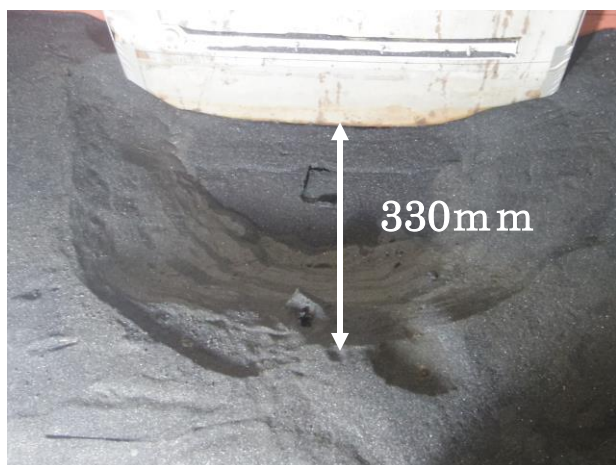
写真-1 崩壊後の地表面
