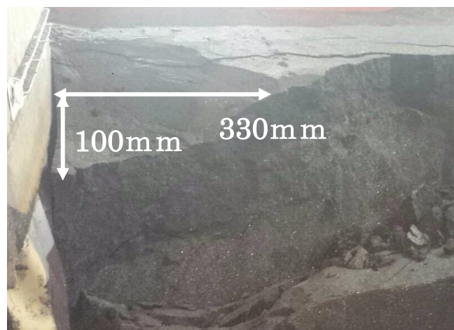
写真-2 崩壊後の断面
