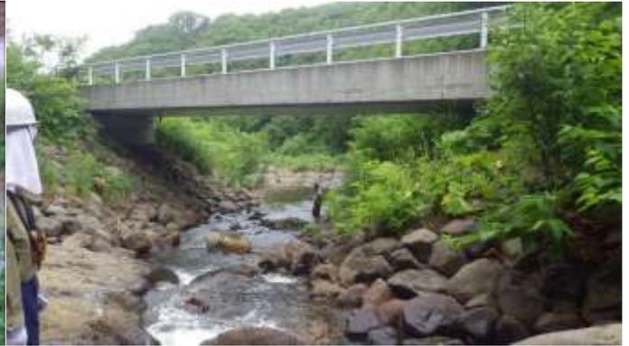
写真4 河道が狭くなって生じた河床低下
