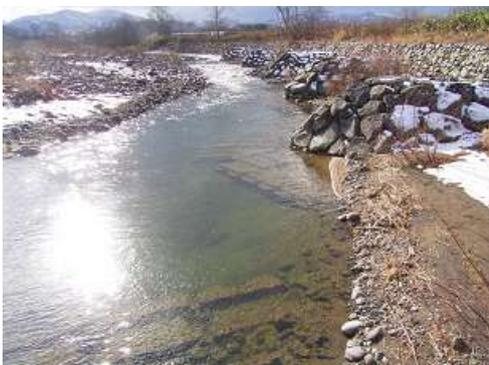
写真9 水制工による河床低下
