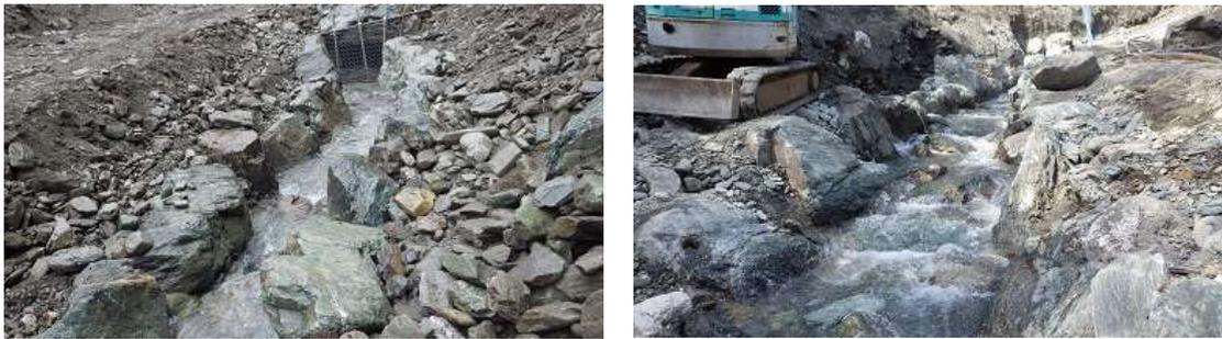
写真-3 巨礫によって蓋を掛ける前の流況確認のために通水している状況
