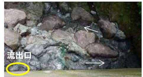
写真-1 水抜き孔から河川に接続する魚道
