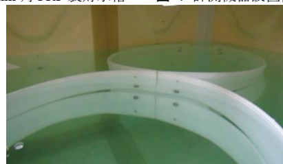
写真-2 浮体式制振装置の設置状況
