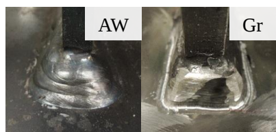
写真-1 溶接止端部・グラインダー処理部
