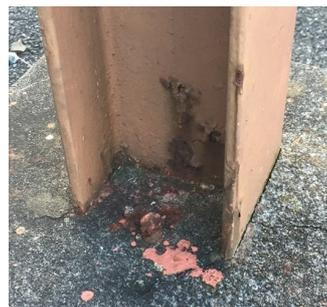
写真-1 柱脚根元の塗装剥離及び腐食
